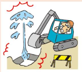
ユーザーが舗装工事中にバックホーの操作を誤り水道管を破裂させた。
