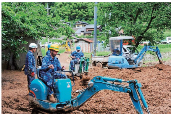
平成30年豪雨災害 器材による土砂の撤去
