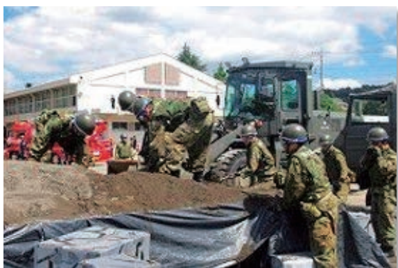
(写真-8) 防災訓練 (神奈川県座間市)
