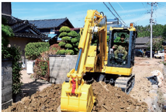
(写真－11) 道路啓開の状況 (白石市)
