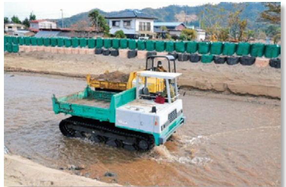
(写真-14) 浚渫の状況 (丸森町)
