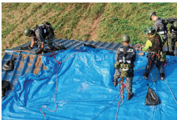
ブルーシートによる応急復旧活動
