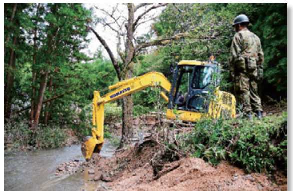
(写真-16) 浚渫の状況 (丸森町)
