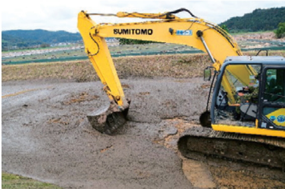
(写真-15) 浚渫の状況 (丸森町)
