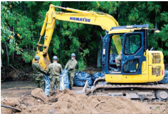
(写真-13) 浚渫の状況 (丸森町)
