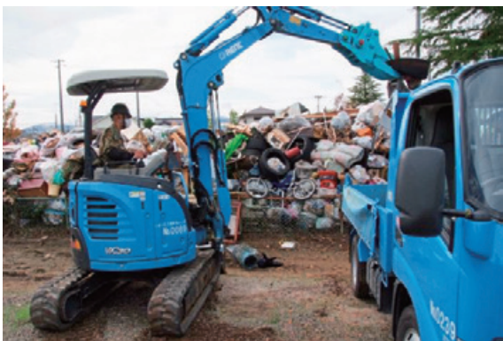
(写真-19) 災害廃棄物撤去の状況 (いわき市)
