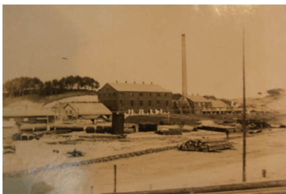
(写真－1) 旧海軍火薬庫の施設（昭和18年頃）
