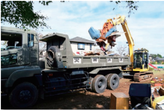
(写真-17) 災害廃棄物撤去の状況 (柴田町)
