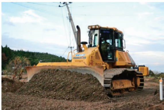
(写真－12) 道路啓開の状況 (丸森町)
