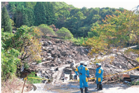
（写真－6）崖崩れの状況（丸森町）
