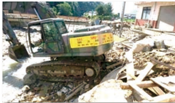
(写真-7) 河川の護岸補修作業の状況 (呉市安浦)
