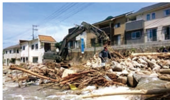
(写真-12) 人命救助活動のための瓦礫除去 (熊野町)
