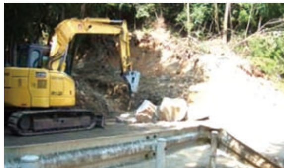
(写真-10) 転石・流木等の除去の状況 (リース器材) (海田町)
