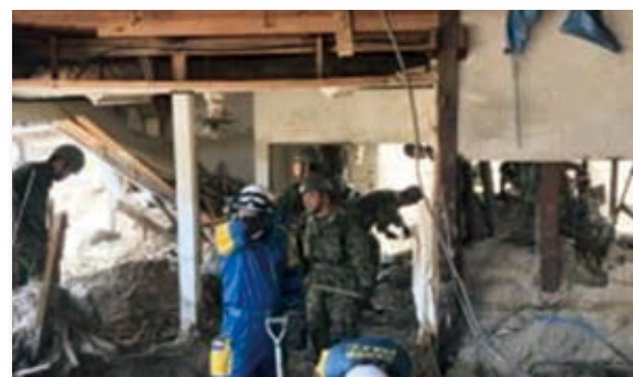
（写真－6）家屋の倒壊状況 （広島県安芸区）
