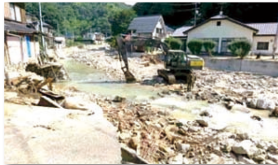
(写真-8) 河川の護岸補修作業の状況 (呉市安浦)
