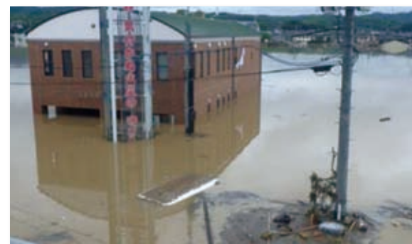
（写真－5）市街地の冠水状況 （岡山県倉敷市）
