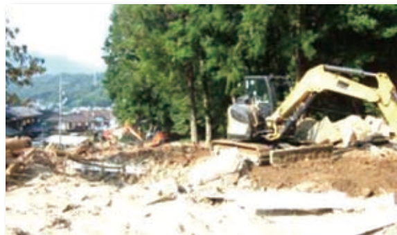
(写真-9) 転石・流木等の除去の状況 (リース器材) (海田町)
