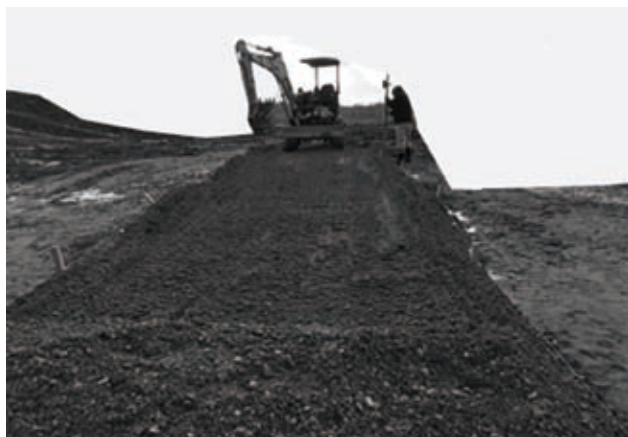
図4 iDig Dozerを使った敷き均し
