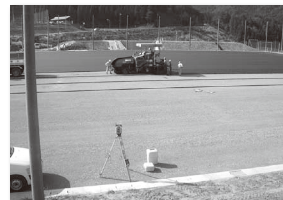
グラウンド施工風景
