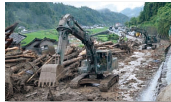
写真-6 油圧ショベル等を使用した行方不明者捜索のための道路啓開状況(福岡県東峰村)
