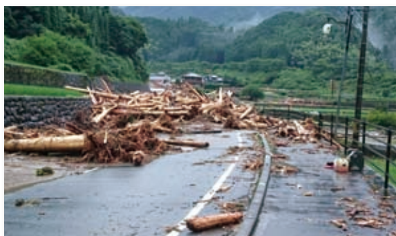
写真-5 大量の流木による道路寸断状況 (福岡県東峰村)
