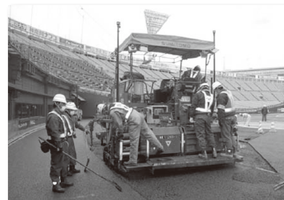
情報化施工風景
