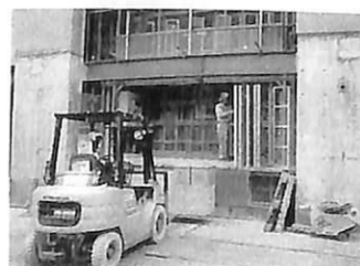
資材をエレベーターに一括搬入
