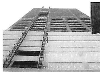
工専用エレベーターで上層階へ
