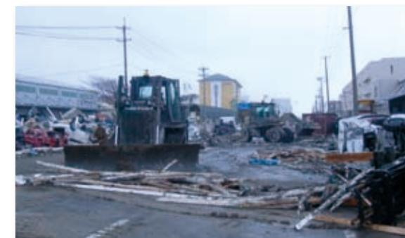
写真-3 ブルドーザによる瓦礫除去
