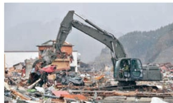
写真-1 バックホウによる瓦礫除去
