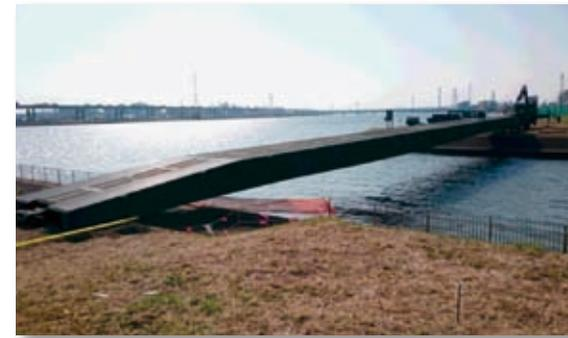
写真-15 防災訓練で架設された07式機動支援橋
