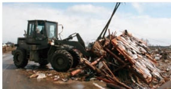
写真-4 ホイールローダーによる瓦礫除去
